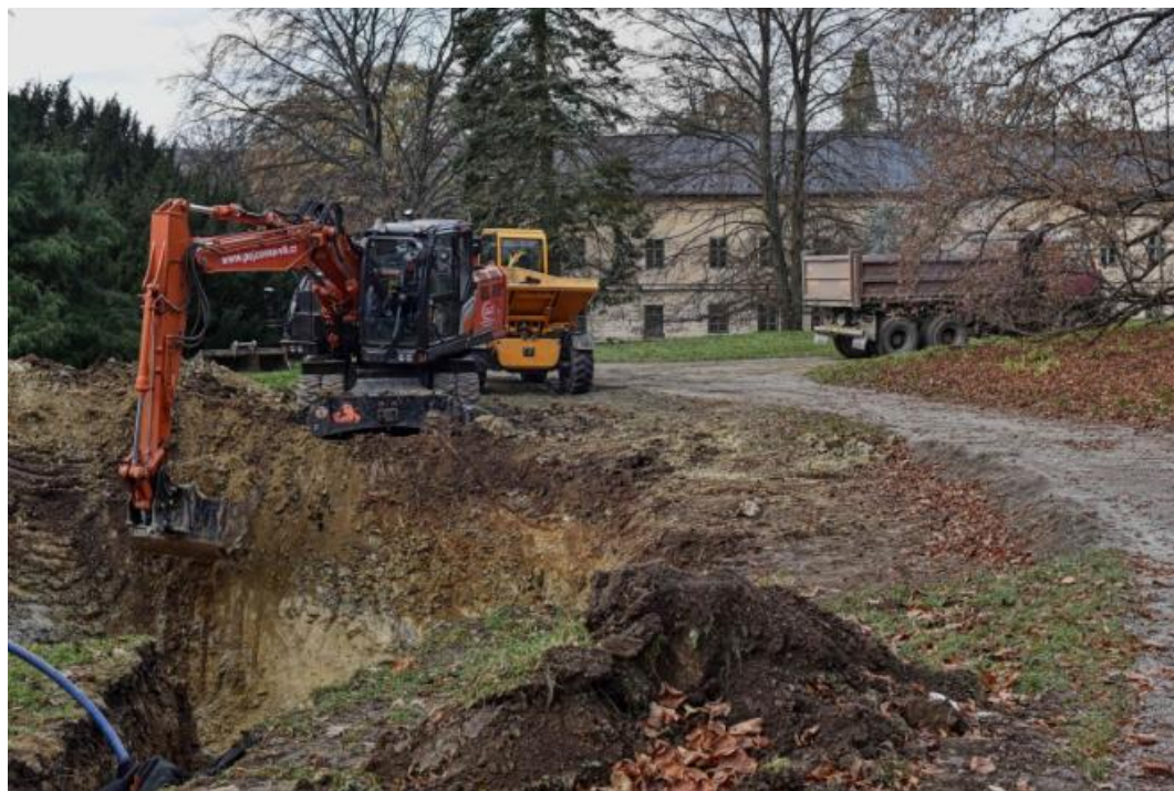
Budování podzemní retenční nádrže (foto: Jaromír Král)
